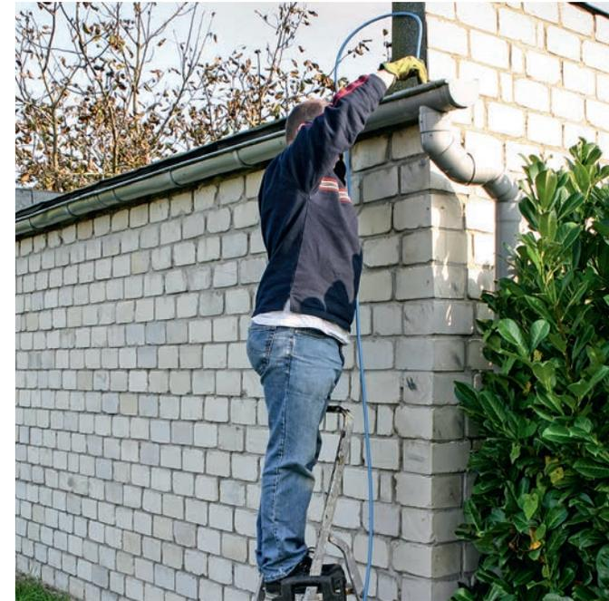
Der Rohrreinigungsschlauch wird mit einem Hochdruckreiniger betrieben. So schiebt sich der Hochdruckschlauch durch den Rückstrahl selbst ins Rohr, wodurch sich ein Wasserstrahl parallel nach vorn durch die Verstopfung bohrt, drei nach hinten gerichtete Wasserstrahlen den Vortrieb verursachen und zeitgleich die Rohrwandungen sauber spülen. (Erforderlicher Arbeitsdruck: 130 - 140 bar) **Kränzle**
