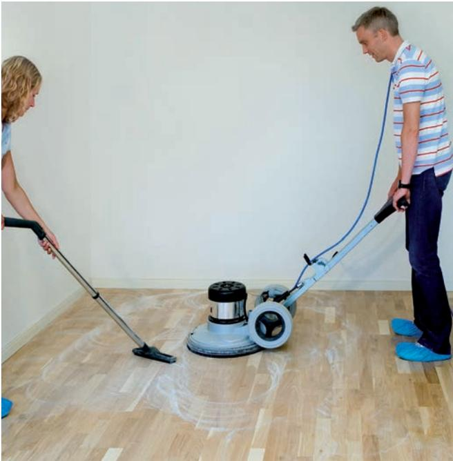
Der Tellerschleifer zeigt sich zuverlässig im Fein- und Zwischenschliff bei Parkett und Kork sowie beim Polieren von Hartböden.
