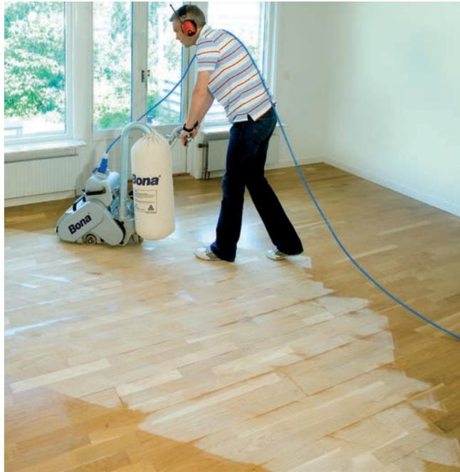
Der wendige und kompakt gebaute Parkettschleifer ist für alle Parkett- und Dielenböden geeignet. Er verfügt über eine sehr wirksame Staubabsaugung und eine elektronische Anlaufstrombegrenzung. Das Endloschleifband ist leicht und schnell zu wechseln, wobei sich der Bandlauf von selbst zentriert.
